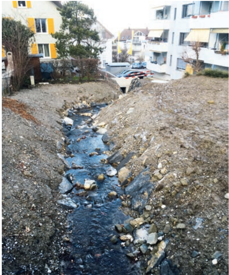
Der Mühltoibelbach fliesst zwischen der Heidenerstrasse und der Schulanlage Mühleobel in Rorschach in einem neuen Bett.
